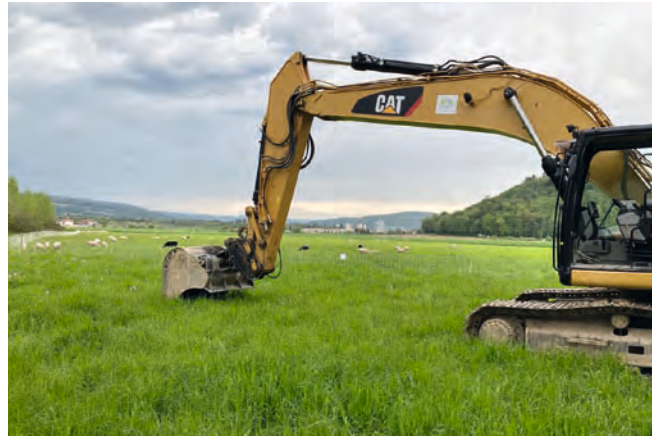
Spatenstich in der Kiesgrube. Foto: JURA Management AG
