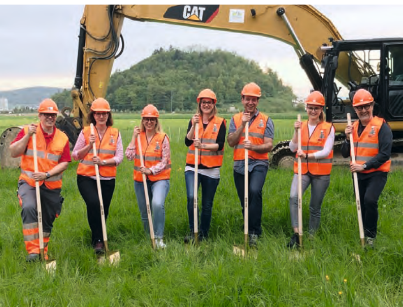
Der Spatenstich für die Kiesgrube Staufen.
