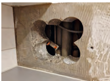
Neuenburgerstrasse 7 bis 12: Bohrarbeiten und Küchenöffnung zur Rohrrinnenreparatur. Fotos: WernliBau AG
