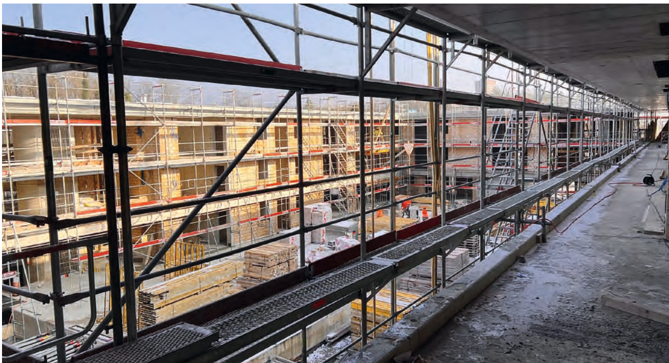
Bauarbeiten auf dem Baufeld 6.
