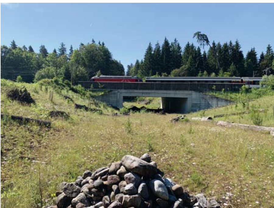
Im Suret-Wald führt eine Eisenbahnlinie mitten durch den Wald. Die SBB gestaltete die ehemalige Wegunterführung für Spaziergänger als Wildunterführung um.
