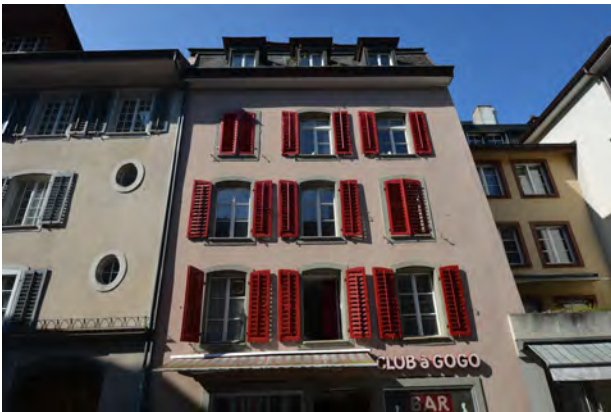
Pelzgasse 33, Zwischen den Toren 14, 28.03.2014.
